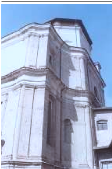
15. Esterno del coro settecentesco.
