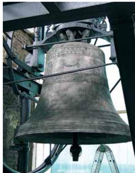
rata illimitata si basa su un sistema logico di movimentazione che permette una perfetta riproduzione dei vecchi sistemi di azionamento a corda lasciando alla campana il naturale movimento di oscillazione con un suono più armonioso e un'autoregolazione del movimento per concerti eseguiti nelle diverse condizioni meteorologiche esterne.
